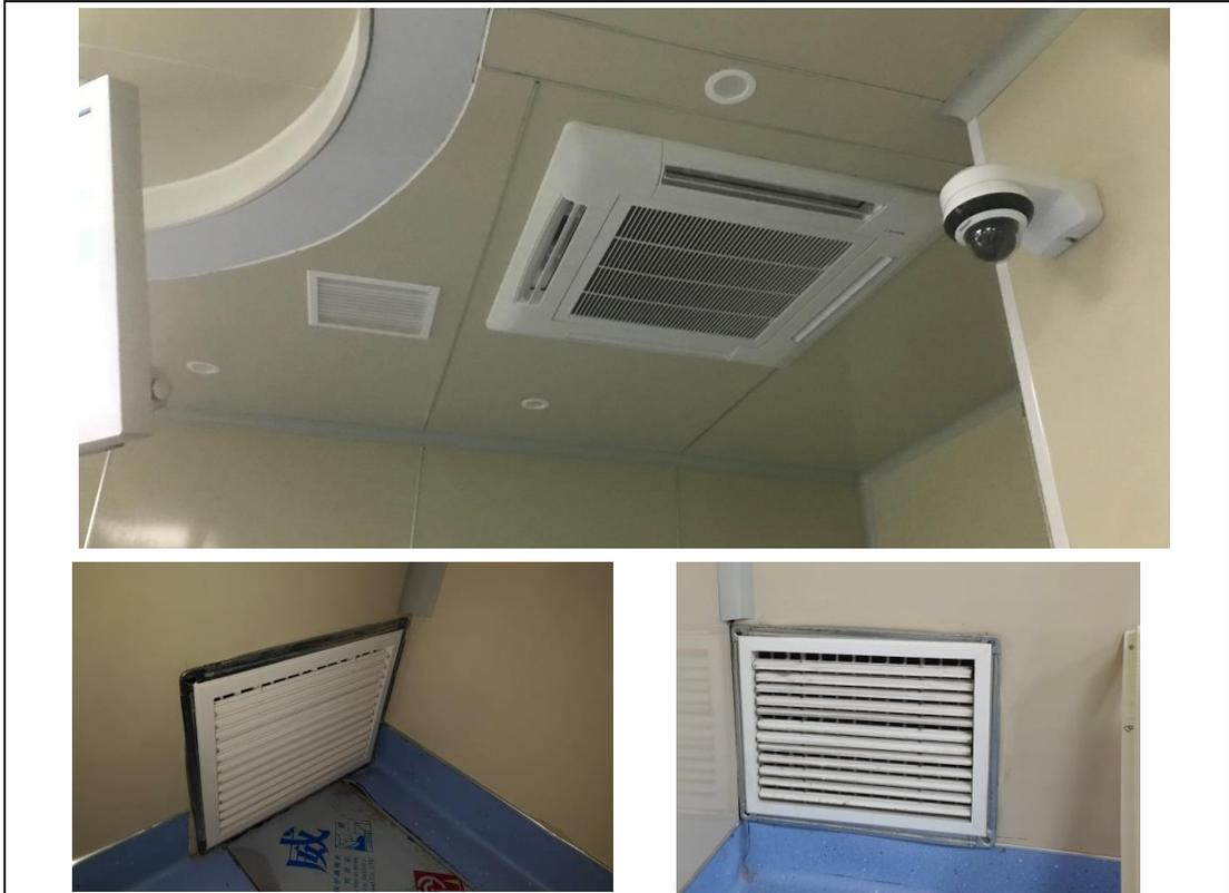
图 3-11 加速器治疗室进风口和排风口现场照片
