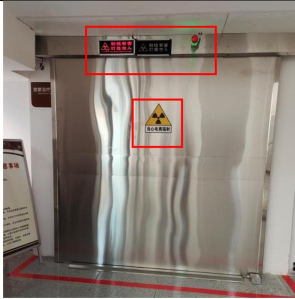
图 3-3 医用直线加速器机房电离辐射警告标志和工作状态指示灯
