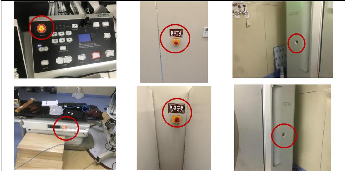
图3-9 本项目加速器治疗室和控制室急停开关
