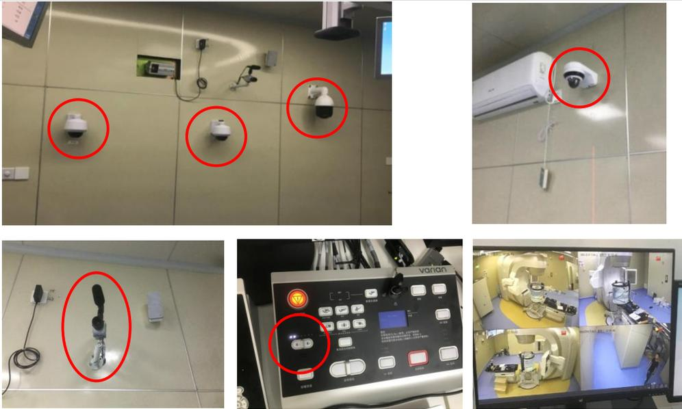
图3-7 本项目加速器机房视频监控和对讲系统
