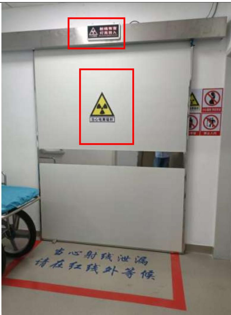
图3-4 DSA机房西侧防护门
