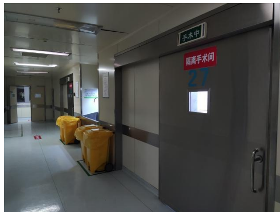
图 8-5 本项目 DSA 机房拟建址西侧 (现状为走廊)
