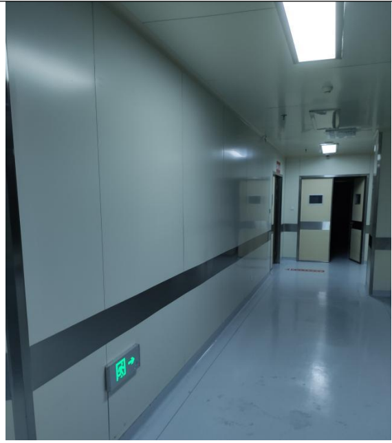
图 8-4 本项目 DSA 机房拟建址北侧 (走廊)
