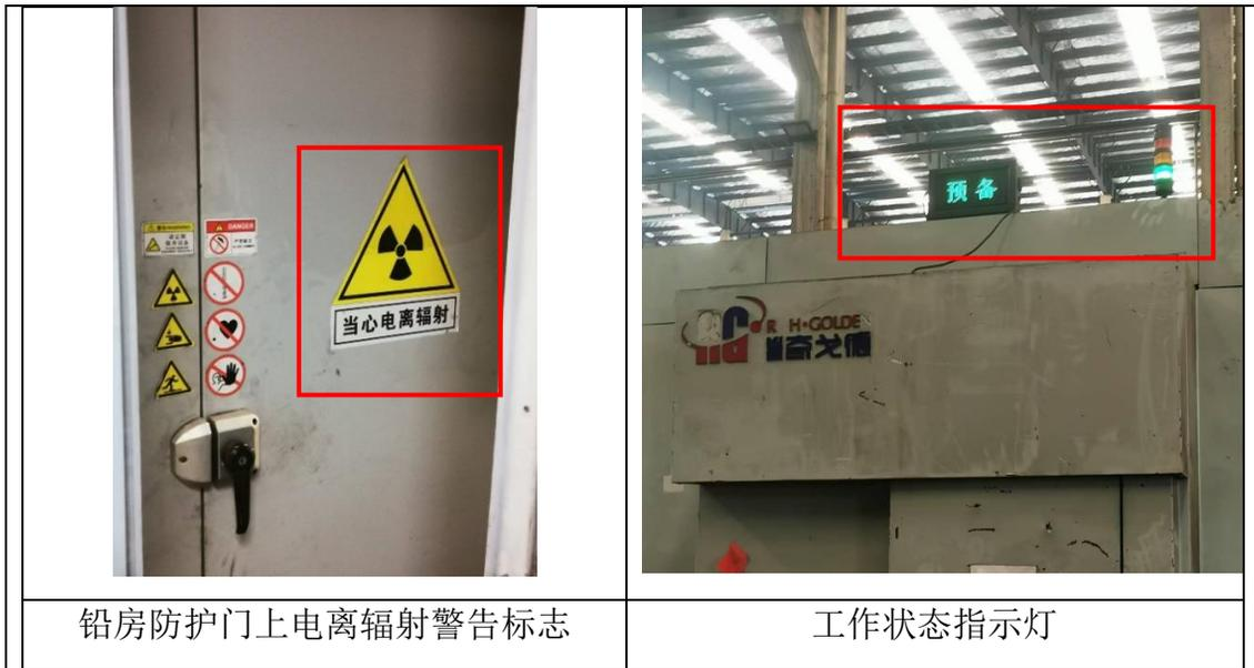
图3-2 本项目屏蔽铅房状态指示灯和电离辐射警告标志
