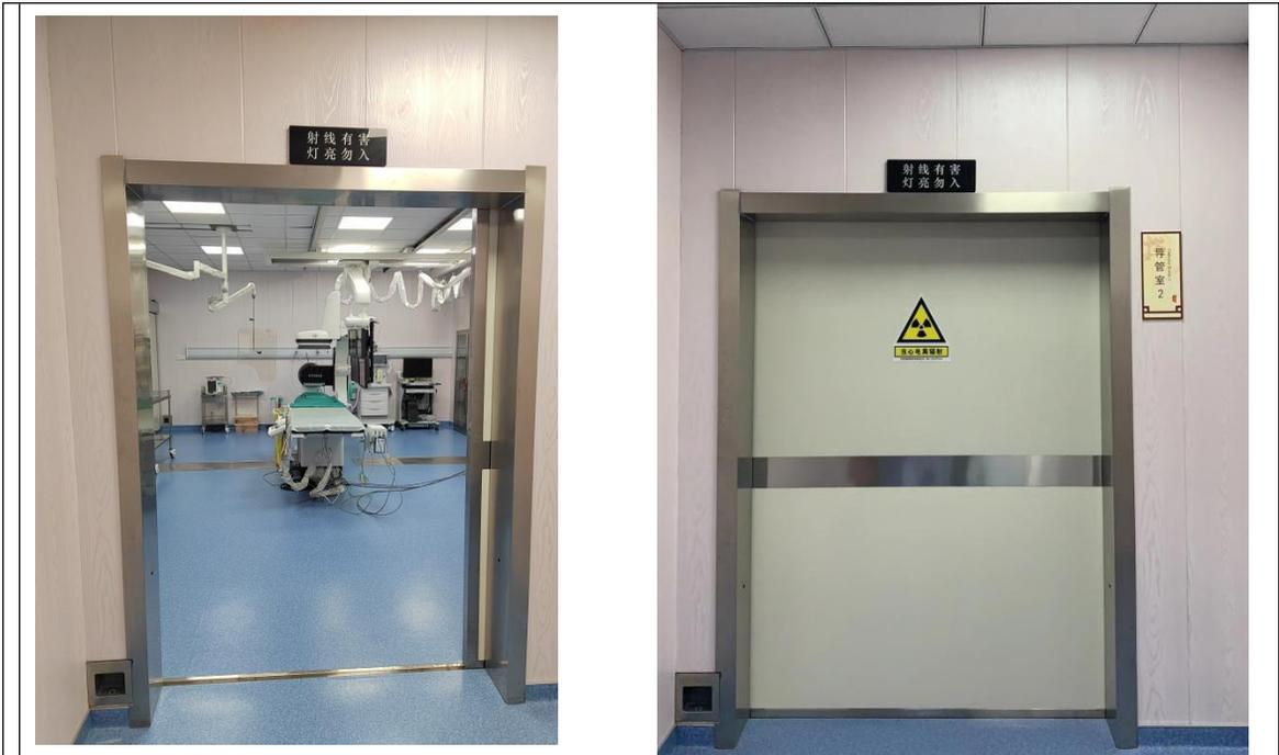
图3-2 工作状态指示灯和电离辐射警告标志
