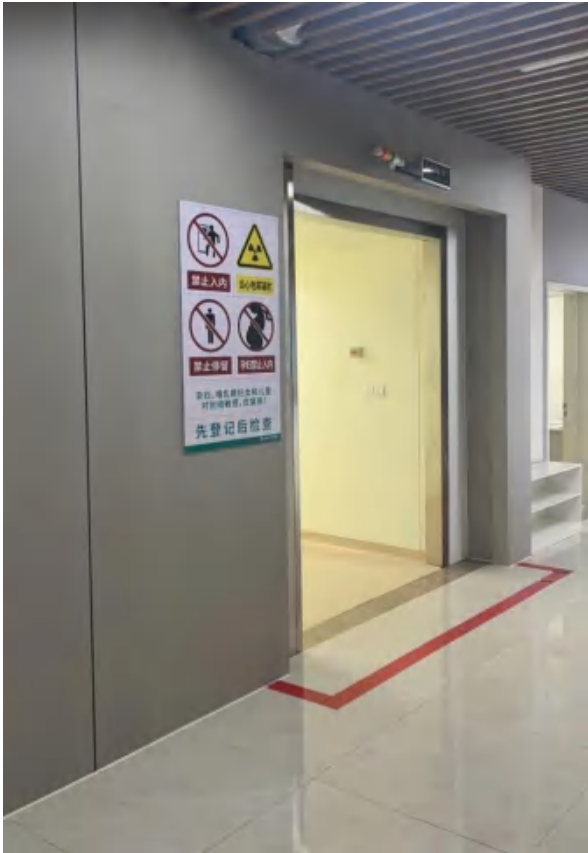
(b) 直线加速器机房防护门
