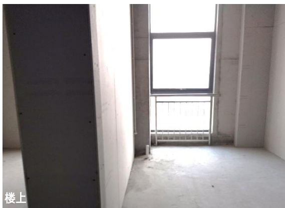
图 8-5 核医学场所拟建址楼上（拟建诊室）
