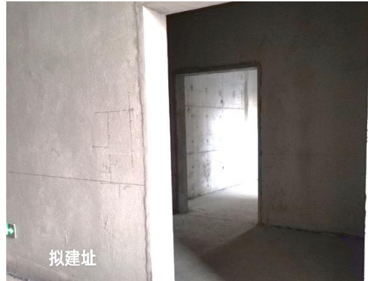
图 8-2 本项目核医学场所拟建址
