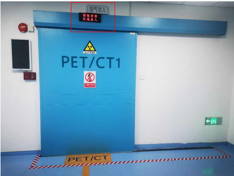
图 3-3 工作状态指示灯及门灯联锁
