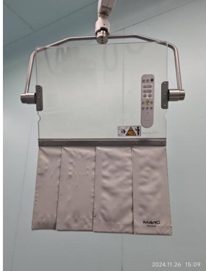
介入治疗中心DSA3室铅床侧防护铅帘、悬挂铅屏风
