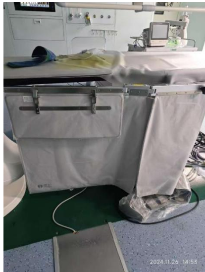
介入治疗中心DSA2室铅床侧防护铅帘、悬挂铅屏风
