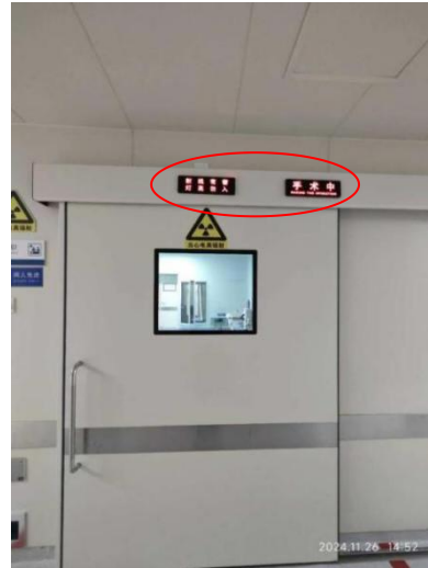
DSA2 室防护大门关闭状态
