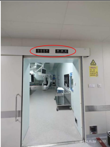
杂交手术室防护大门打开状态
