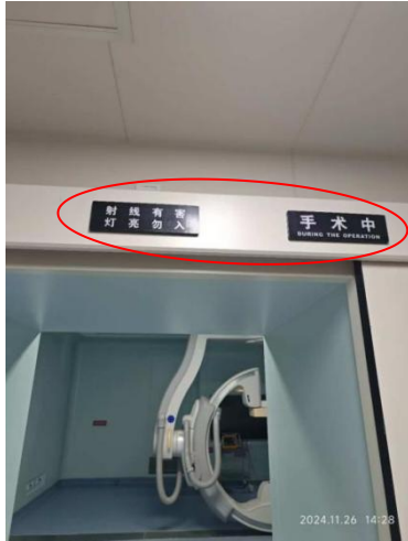
DSA1 室防护大门开启状态
