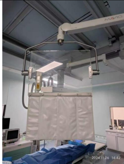
介入治疗中心DSA1室铅床侧防护铅帘、悬挂铅屏风
