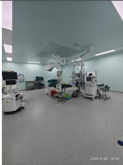
杂交手术室东侧 RO2 手术室
