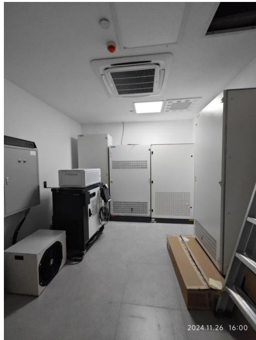
杂交手术室西侧设备间
