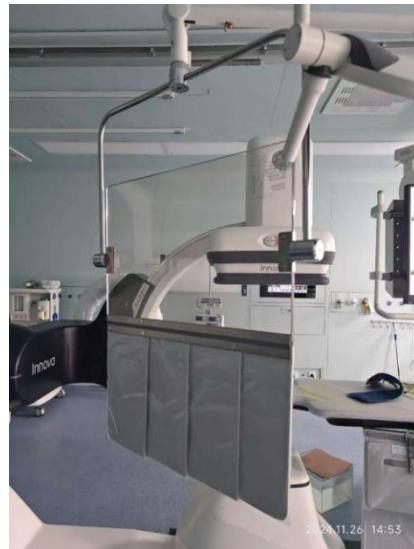
介入治疗中心DSA2室铅床侧防护铅帘、悬挂铅屏风
