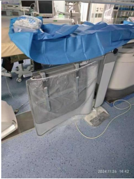
介入治疗中心DSA1室铅床侧防护铅帘、悬挂铅屏风
