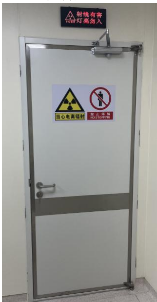
PET/CT机房控制室门
