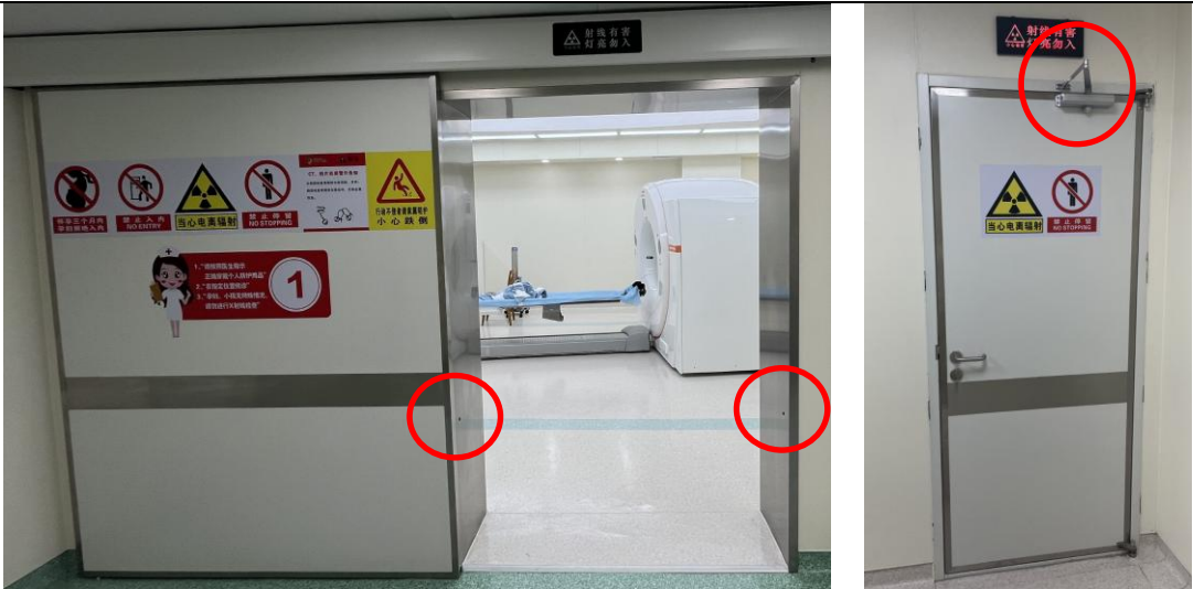
PET/CT机房大门（防夹装置）
