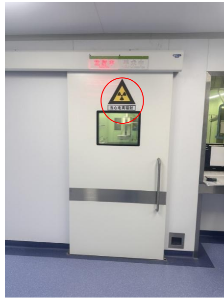
3号楼三楼DSA3室防护小门
