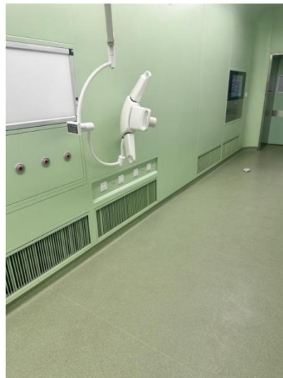
图 3-11 本项目 DSA 机房排风装置
