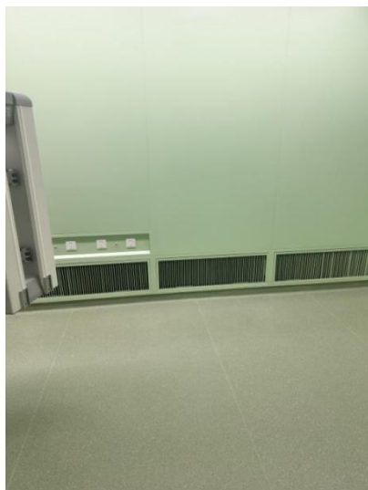
图 3-11 本项目 DSA 机房排风装置
