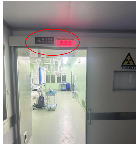
3号楼三楼 DSA3 室防护大门打开状态
