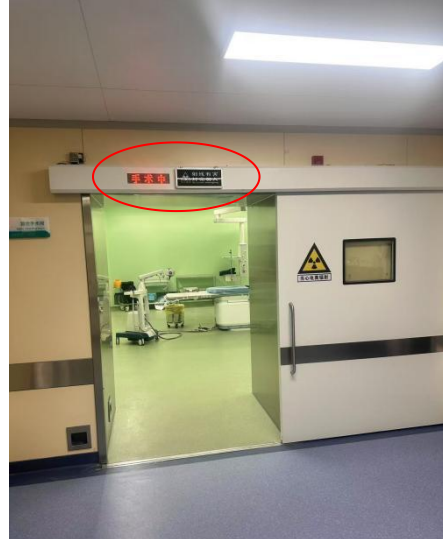
7号楼一楼 DSA 机房防护大门打开状态
