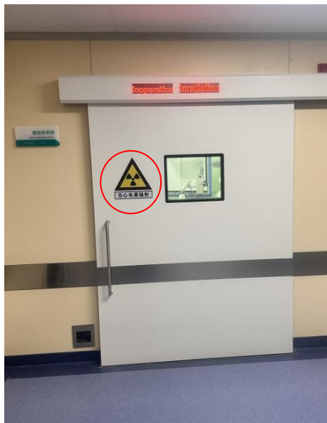
7号楼一楼DSA机房防护大门
