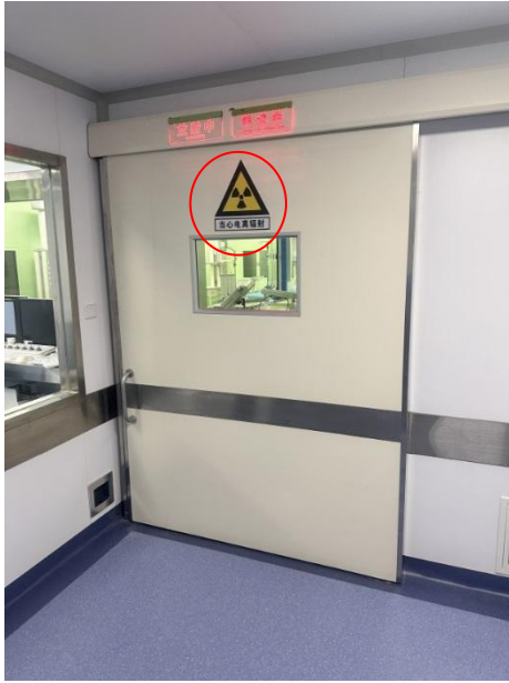
3号楼三楼DSA3室防护大门
