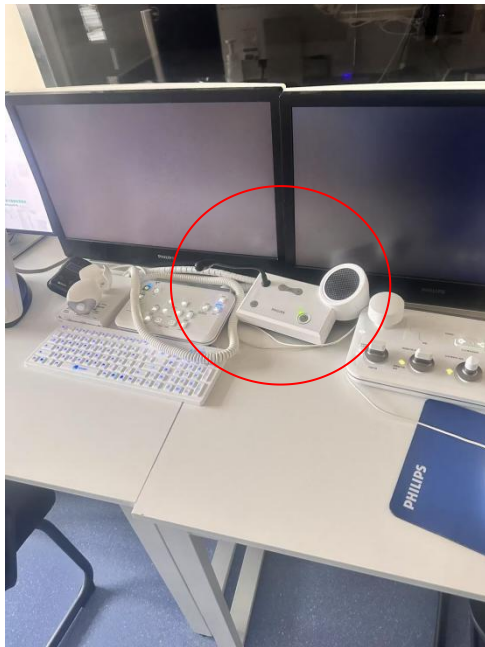
3号楼三楼DSA3室对讲装置
