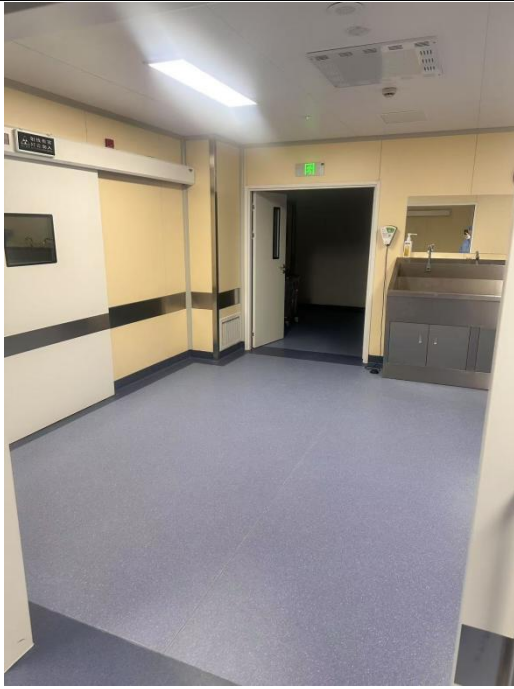
DSA 机房南侧缓冲前室和污物走道
