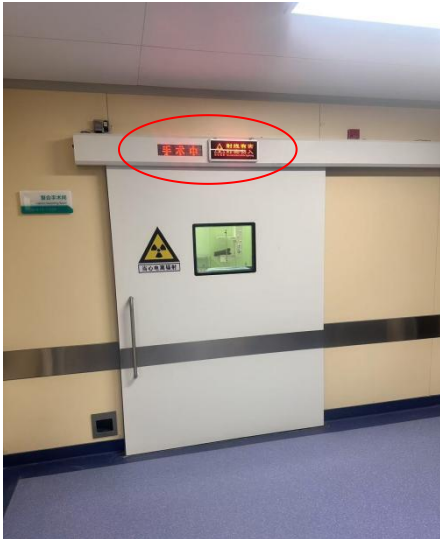
7号楼一楼 DSA 机房防护大门关闭状态
