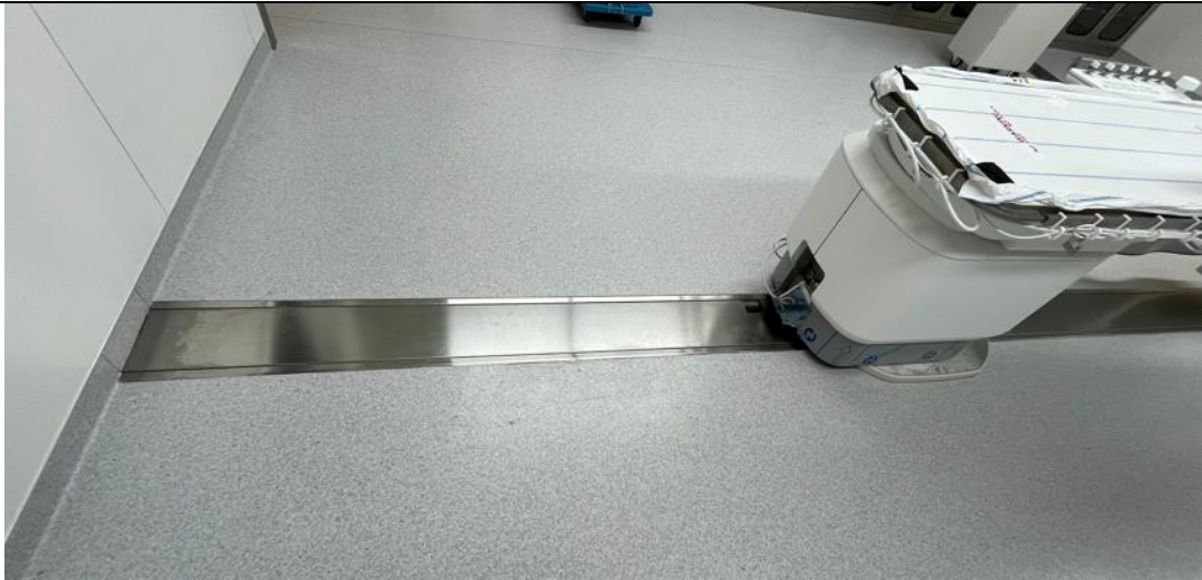
图3-5 地下“U”形管线布设
