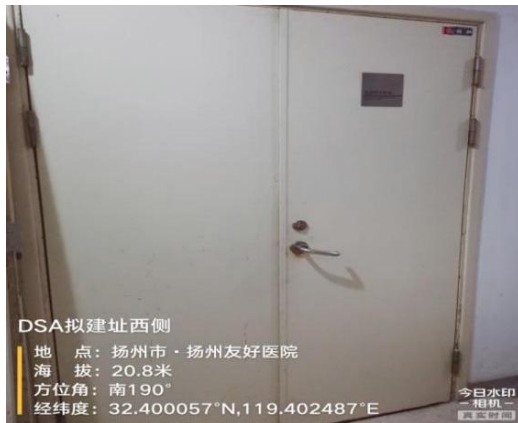
图 8-4 本项目 DSA 机房及配套附属功能房拟建址西侧（空调机房）
