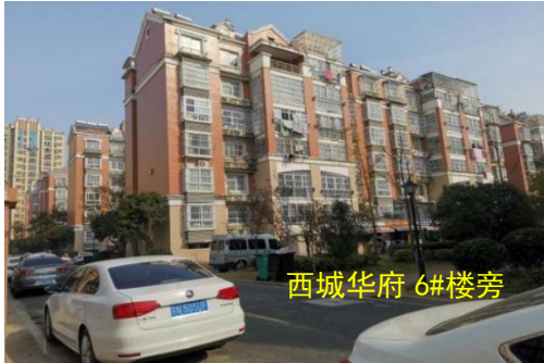
图 8-7 DSA 机房拟建址东侧
