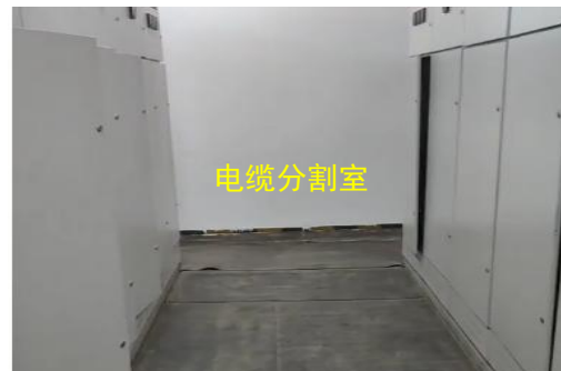
图 8-4 DSA 机房拟建址西侧
