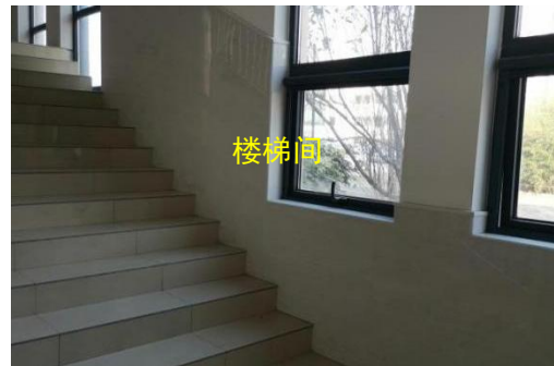
图 8-2 DSA 机房拟建址东侧
