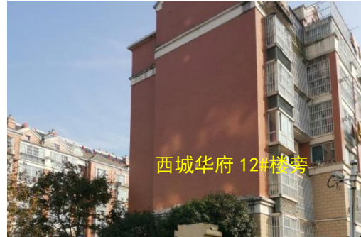
图 8-8 DSA 机房拟建址东侧
