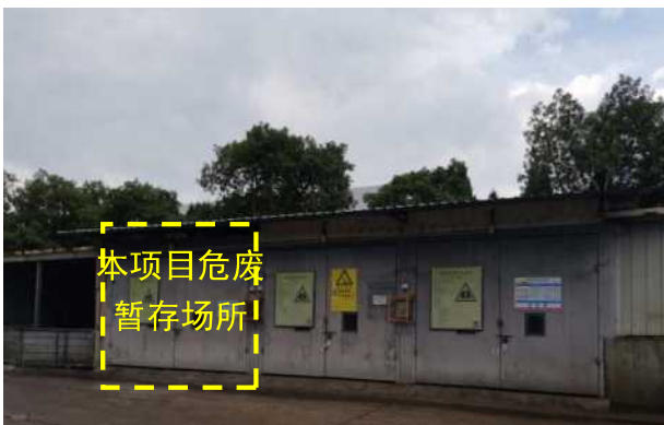
图 8-9 厂区东北角危废库
