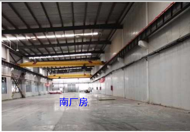
图 8-5 固定式 X 射线探伤铅房拟建址北侧
