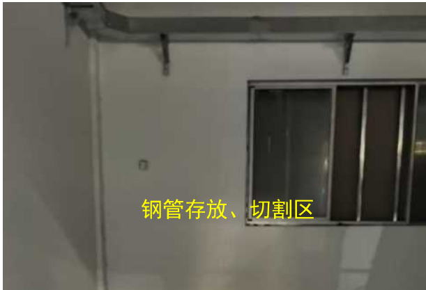
图 8-2 固定式 X 射线探伤铅房拟建址东侧
