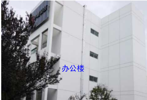
图 8-7 厂区内办公楼
